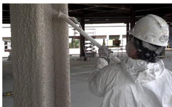
Figura 3 – Aplicação de argamassa projetada em pilar metálico Fonte: Arabian Vermiculite Industries (2016)
