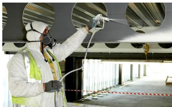
Figura 4 – Aplicação de tinta intumescente em viga celular Fonte: Tornado (2020)
